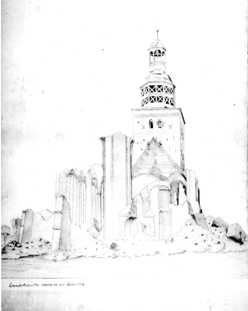
Die Lambertikirche während des Abbruchs
