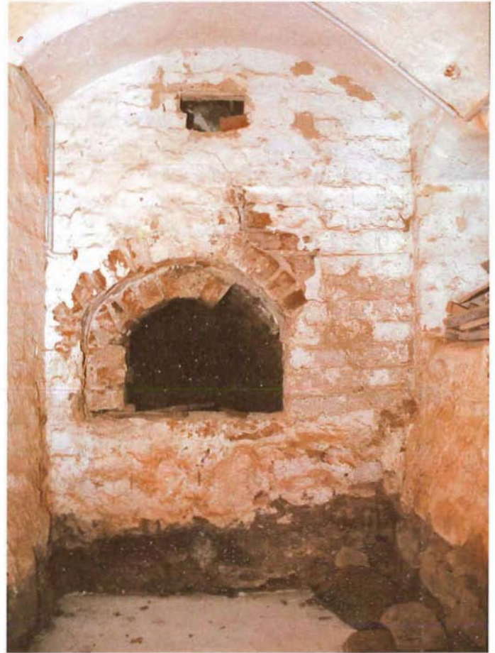
Abb. 4: Kloster Ebstorf: Öffnung zum Feuerungsraum der Heißluftheizung
