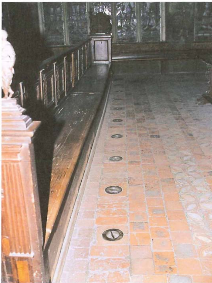
Abb. 2: Rathaus Lüneburg, Gerichtslaupe: mit Bronzedeckeln verschlossene Lochsteine
